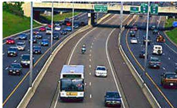
Calzada VAO separada por barreras Dos carriles de flujo reversible
