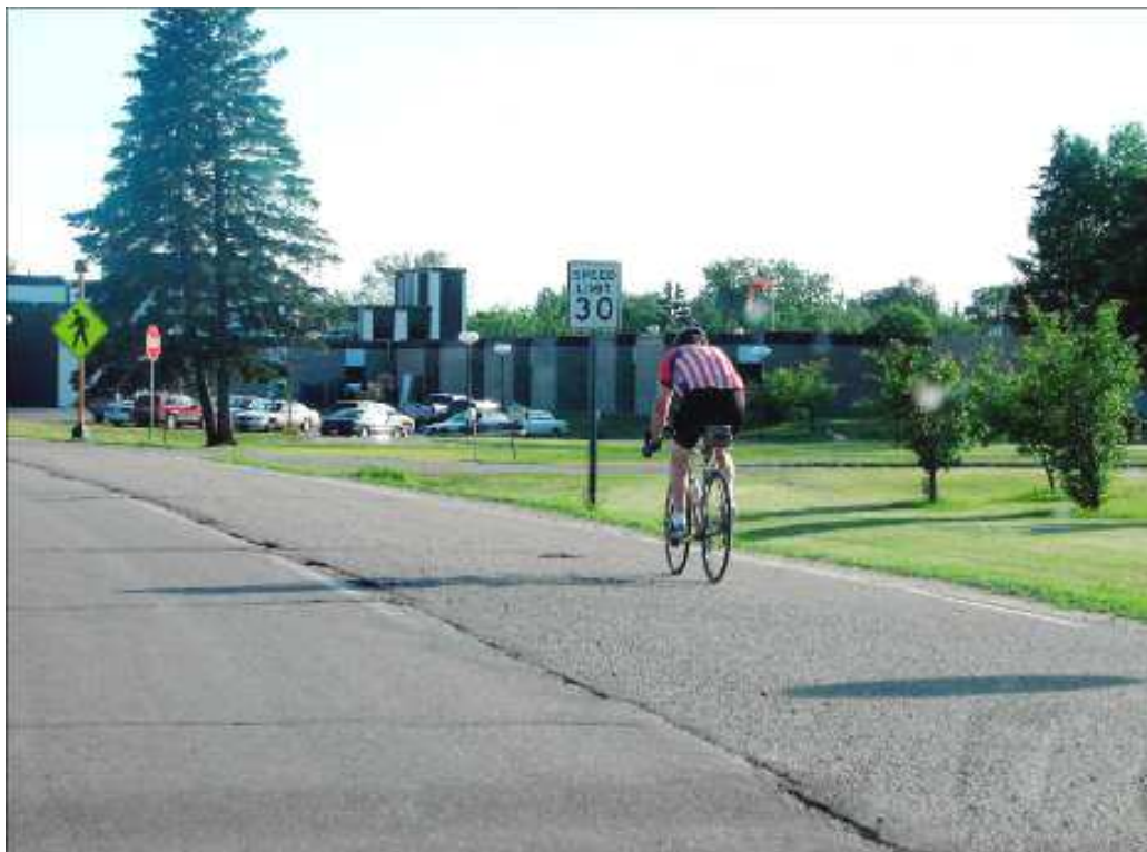
Figura 8.26 Suave banquina pavimentada disponible para uso ciclista
