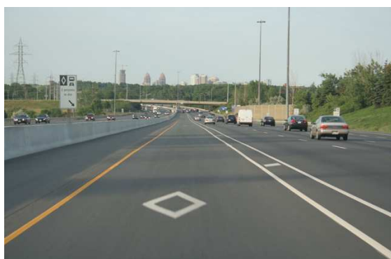
Carriles VAO separados por barrera + pintura Dos carriles dos sentidos
