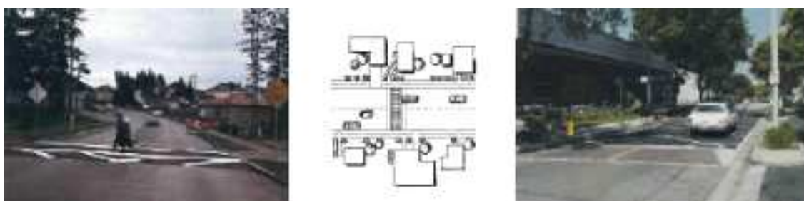
Figura 8.68 Cruces peatonales elevados
